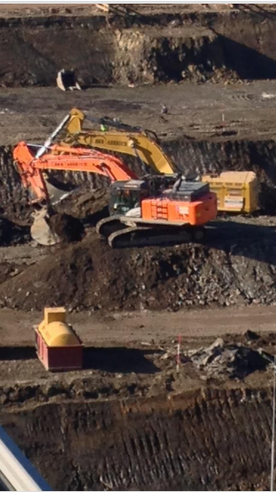
Baugrube RUB-Gebäude IB Quelle: TLB
