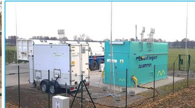
Einspeiseanlagen in Schopssdorf bei Berlin zur Versorgung von ca. 350 Haushalten mit einem H<sub>2</sub>-Erdgasgemisch (20/80)
