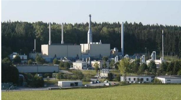
Dabei wird der eigentliche Verdichter meist durch eine Gasturbine angetrieben, die mit Brenngas aus der Pipeline mitversorgt wird
