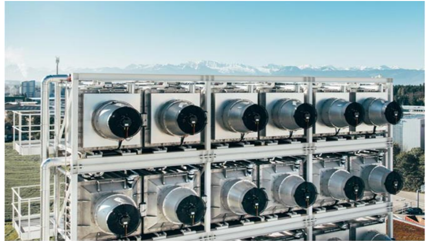
Mit Direct Air Capture-Anlagen wird CO 2 aus der Atmosphäre abgeschieden (© Climeworks, Julia Dunlop).
