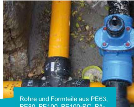
Rohre und Formteile aus PE63, PE80, PE100, PE100-RC, PA-U12 und PVC sind grundsätzlich für die Anwendung mit H<sub>2</sub> geeignet (siehe auch F&E-Projekt G 202222).
