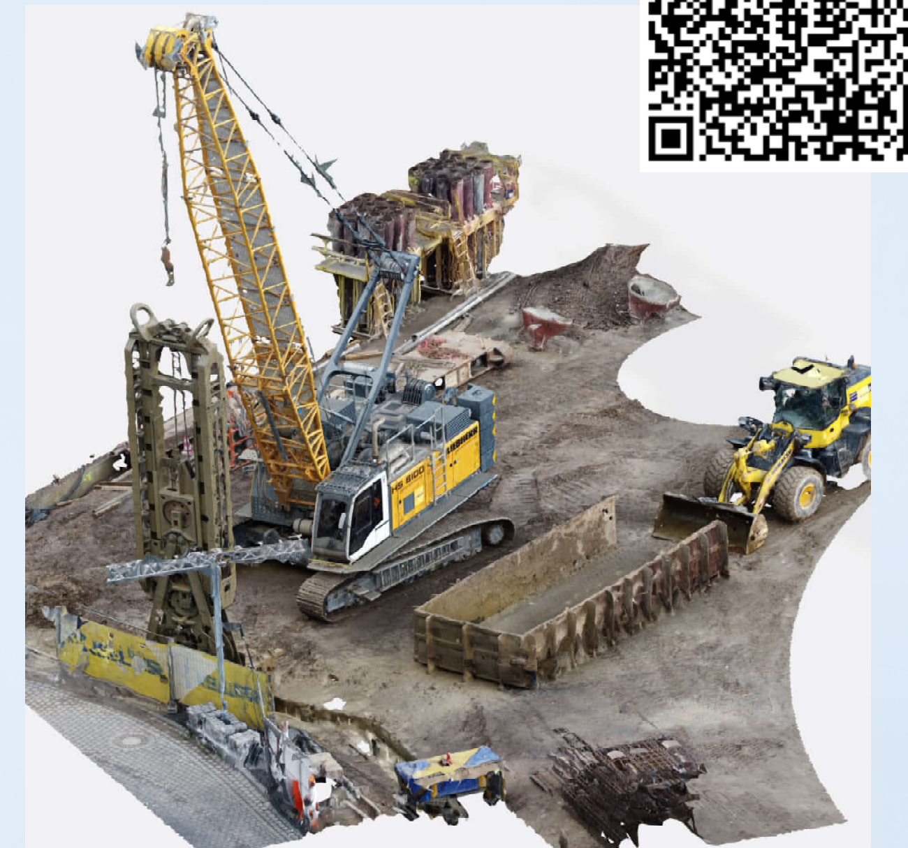
3D-Modell zur Begehung einer Baustelle während der Herstellung einer Schlitzwand (Kosmann et al., 2023)
