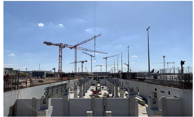
Flughafen Frankfurt a.M., Terminal 3
