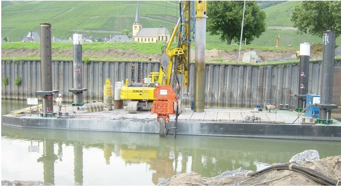
Stahlpfähle werden vom Schwimmponton aus gezogen
