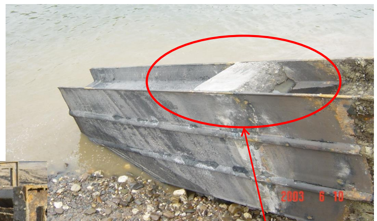
Betonreste am Pfahlfuß
