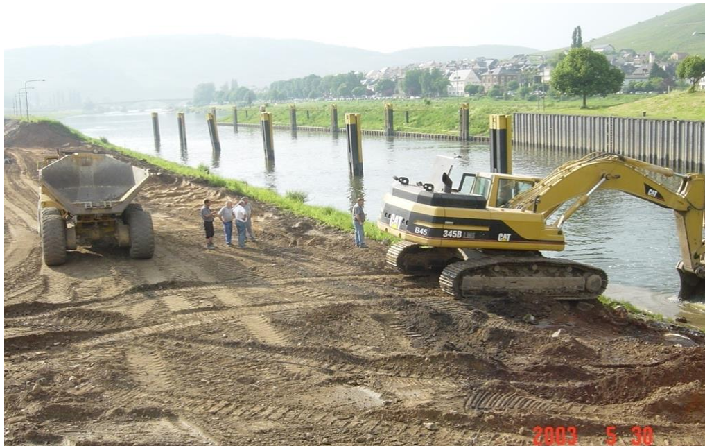
Unterer Vorhafen mit Bestandspfählen
