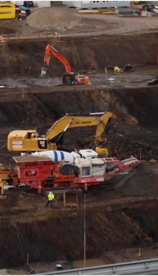
Baugrube RUB-Gebäude IB Quelle: TLB
