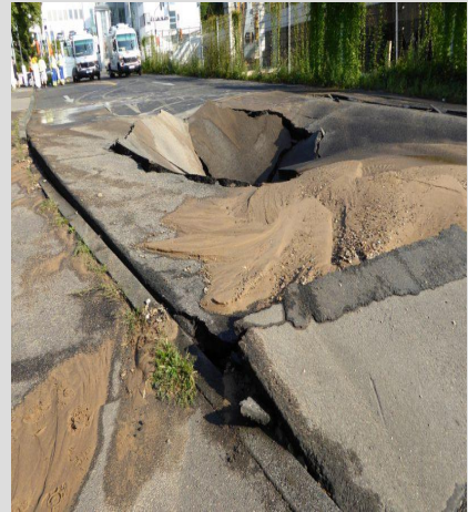
Wasserrohrbruch
