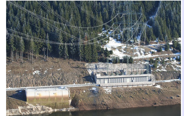
Auslaufbauwerk und Energieableitungsportal, Störfix, CC-BY-SA 3.0† https://de.wikipedia.org/wiki/Pumpspeicherwerk_Goldisthal#/media/Datei:Goldisthal-PSW-Unterbecken.jpg
