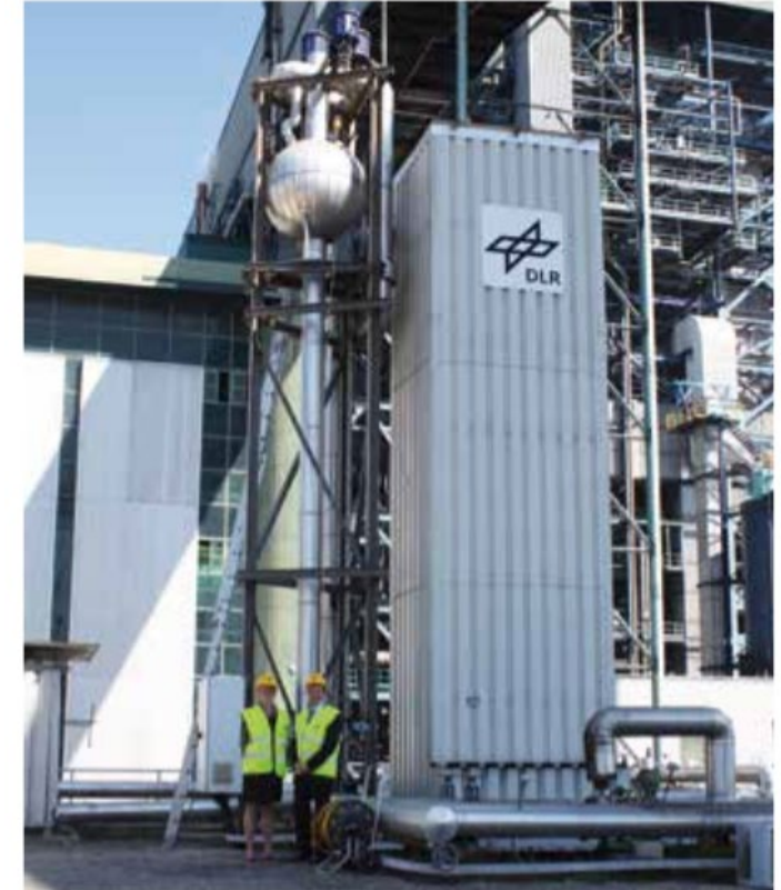
Abb.1 Mit den 14 Tonnen Natriumnitratsalz dieses weltgrößten Latentwärmespeichers lassen sich 700 kWh thermischer Energie bei 300°C speichern. Der Speicher wurde in ein Dampfkraftwerk im spanischen Carboneras integriert und absolvierte dort erfolgreich hundert Zyklen. Solche Konzepte eignen sich besonders für solarthermische Kraftwerke mit Direktverdampfung.
