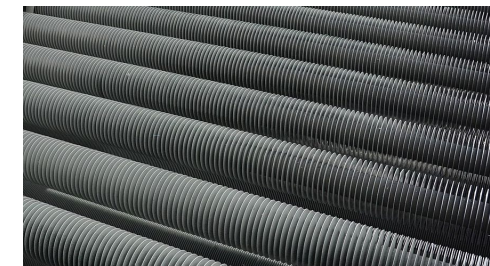
Rippenrohre eines dampfbeheizten Wärmetauschers, Sensenschmied, CC-BY-SA 3.0† https://de.wikipedia.org/wiki/Rippenrohr#/media/Datei:Rippenrohre_DampfLUVO_Biomasseheizkraftwerk_Steyr.jpeg
