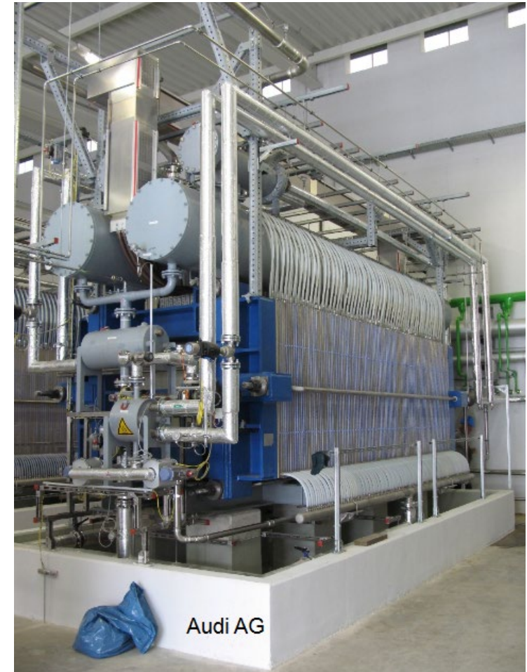
Audi / EWE e-gas Anlage Werlte (2011) 3 Stacks à 2 MW Stromdichte: 0,3 A/cm 2 Zellfläche: 3 m 2
