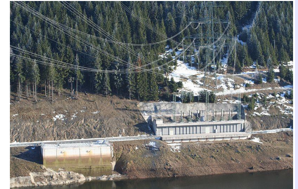
„Unterbecken des PSW in Goldisthal“, Störfix, CC-BY-SA 3.0†; https://de.wikipedia.org/wiki/Pumpspeicherwerk_Goldisthal#/media/Datei:Goldisthal-PSW-Unterbecken.jpg
