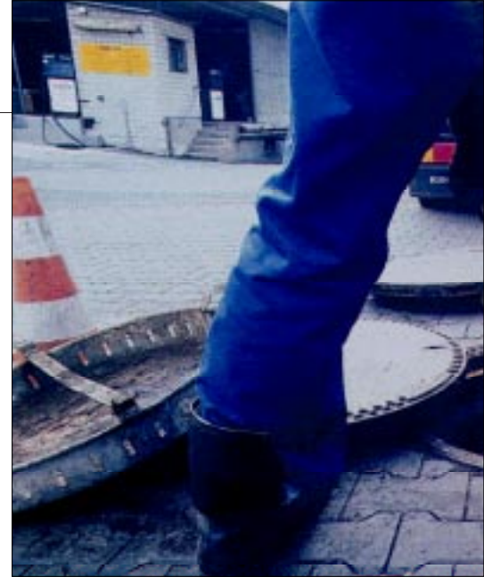
Entsorgung von Altöl an einer Tankstelle:
