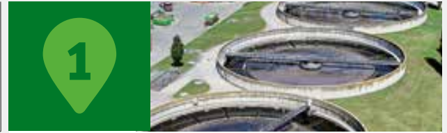
Neubau der Kläranlage Westerburg in Rheinland-Pfalz
