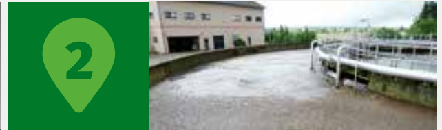
Ausbau der Sammelkläranlage Öhringen in Baden-Württemberg
