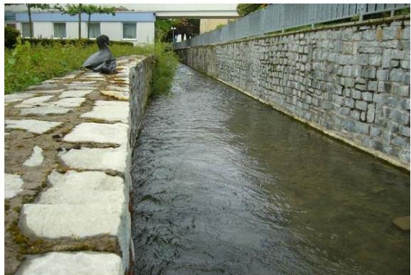
technisches Regelprofil (Kastenprofil)
